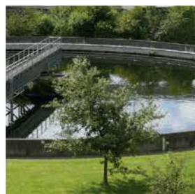
Tratamiento de agua
